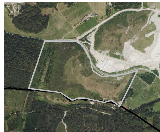
Vue aérienne du site accueillant la centrale photovoltaïque Aménagement en cours de finalisation
