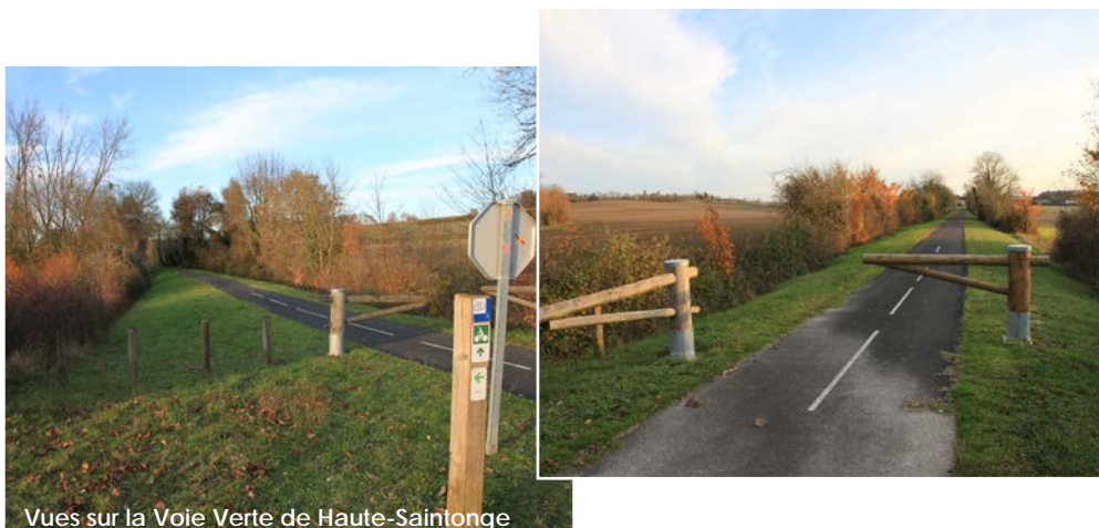
Vues sur la Voie Verte de Haute-Saintonge
